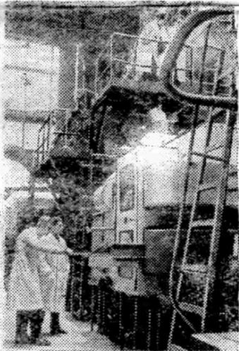
**МОСКВА.** Ученые Института высоких температур Академии наук СССР и инженеры-экспериментаторы Министерства энергетики и электрификации СССР создали модельную экспериментальную энергетическую установку «У-02» с магнетогидродинамическим генератором для прямого преобразования тепловой энергии в электрическую, без посредников — котлов, в которых образуется пар, без турбин, вырабатывающих электрический генератор, и т. д.
