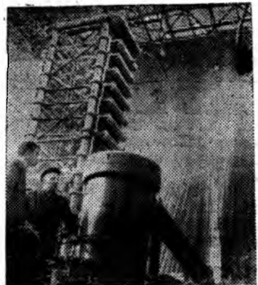
На Московском электрозаводе вступает в строй крупнейший в Союзе цех сборки мощных трансформаторов и генераторов.
