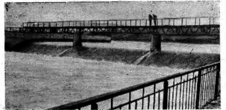
В Дагестане ведется строительство новых и модернизация старых оросительных систем. Закончены работы по реставрации и старейшей системы республики Юзбаш. Теперь воду реки Курах получают 80 тысяч гектаров Кумыкской степи — это вдвое больше, чем до реконструкции.
