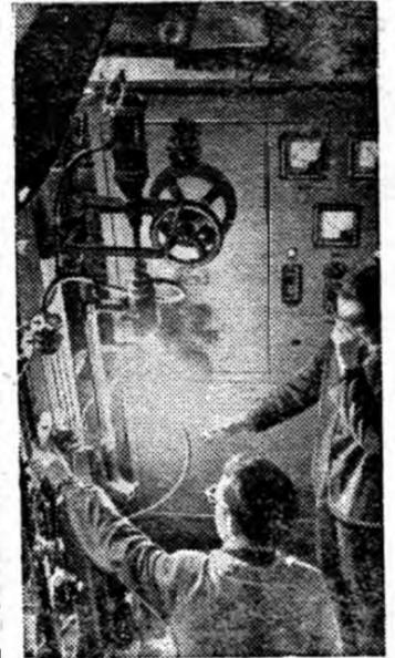
ЛЕНИНГРАД. Сотрудники Всесоюзного научно-исследовательского института токов высокой частоты имени В. П. Волгодина создали плазменные горелки большой мощности с температурой пламени 10—15 тысяч градусов. Эти горелки можно с успехом использовать для плавки самых тугоплавких материалов и в качестве источников света большой яркости. С их помощью получают искусственные кристаллы рубина и сапфира.
