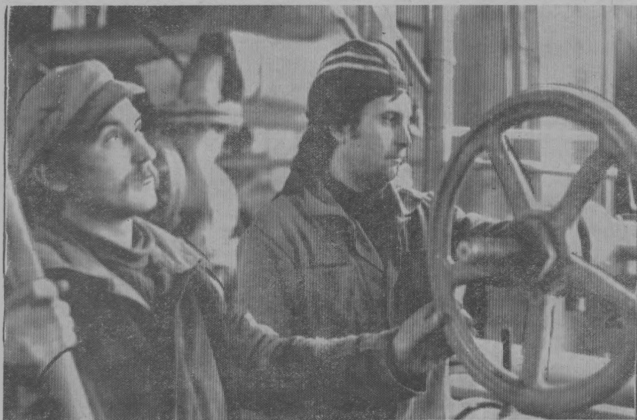
Участок теплоснабжения энергоцеха корпу-са № 3. Большую работу по подготовке комму-никаций к зиме провели сварщик В. П. Босов
