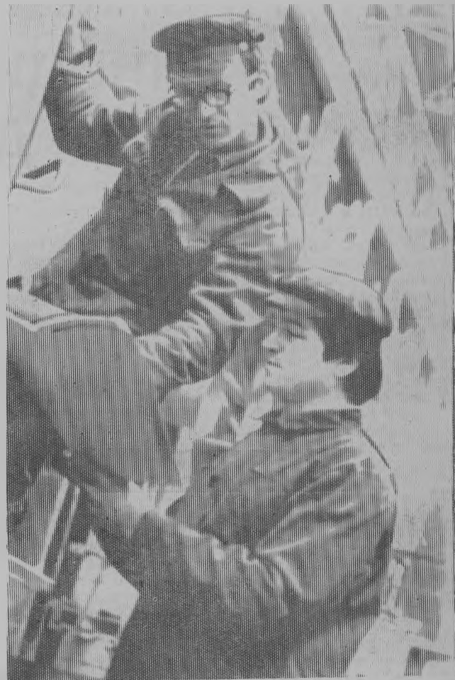
Бригада слесарей-сборщиков из цеха закладных деталей, возглавляемая В. Устиновым, специализируется в основном на изготовлении узлов тепловой защиты реактора.
