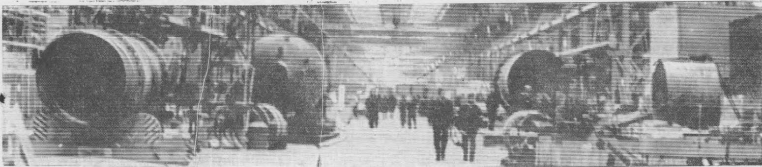
В канун Нового года успешно прошел гидротестирование корпус реактора для Балаковской АЭС. Полным ходом идет сборка первого атоммашевского парогенератора, шлюзов и трубных проходов для атомных электростанций страны.
